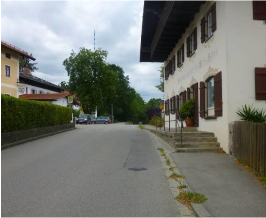
Abb. 89: Fehlende Barrierefreiheit durch abgetreppten Gehwegverlauf, Dorfstraße, eig. Aufn
