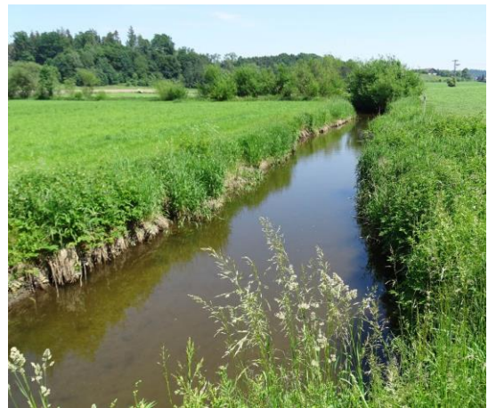
Abb. 125: Begradigter Abschnitt Nasenbach, eig. Aufnahme
