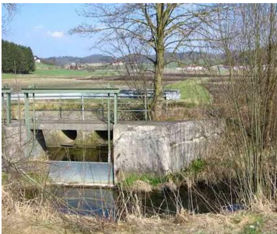
Abb. 124: Techn. Bauwerk zur Ableitung des Nasenbaches nach Norden, www.panoramico.com , 2014
