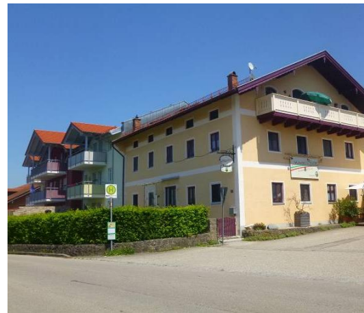
Abb. 44: Restaurant „Salvatore & Massimo“, Dorfstraße 4, eig. Aufnahme
