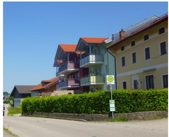
Abb. 97: Falsche Höhenentwicklung mit Dachausbau an der Dorfstraße, eig. Aufnahme
