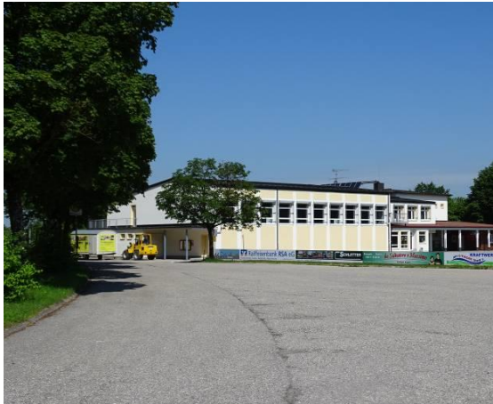
Abb. 93: Großflächig versiegelter Parkplatz am Sportplatz/Grundschule, eig. Aufnahme
