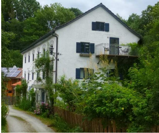
Abb. 105: Ehem. Mühle, Mühlthal, Hs. Nr. 15
