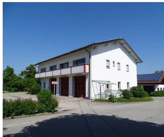
Abb. 64: Feuerwehrhaus, dahinter Bauhof, eig. Aufnahme
