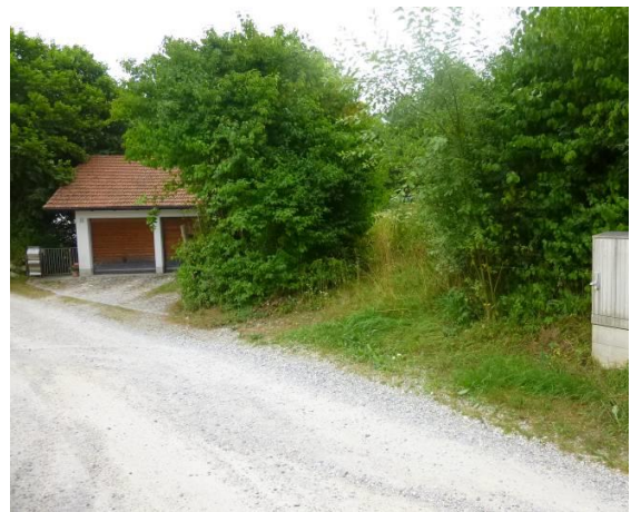
Abb. 99: Starke Verbuschung der Gehölzhecke verdeckt Zugang und Blick auf denkmalgeschützte Wegkapelle, Mühlthal, eig. Aufnahme
