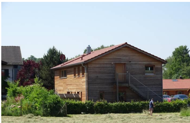
Abb. 107: Wohnhausneubau in Holzbauweise, Strandweg 6, eig. Aufn.
