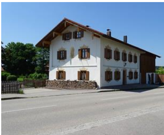
Abb. 103: Hofanlage, Alleestraße 27, eig. Aufnahme
