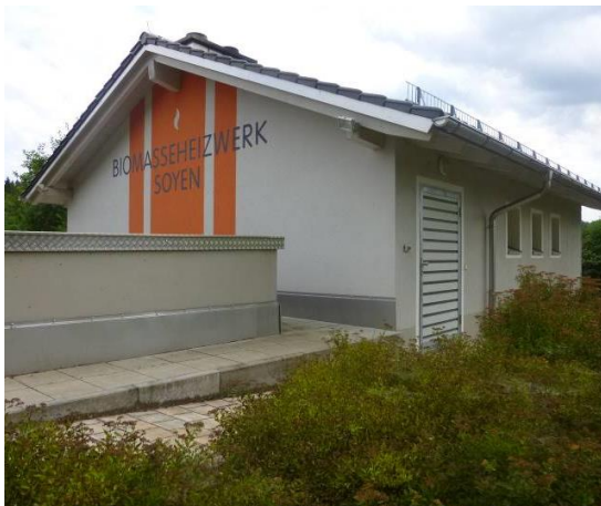
Abb. 43: Biomasseheizkraftwerk am Sportplatz, eig. Aufn.
