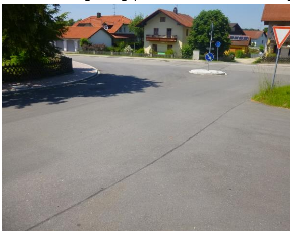
Abb. 128: Überdimensionierter Einmündungstrichter Kitzbergstraße, eig. Aufn.
