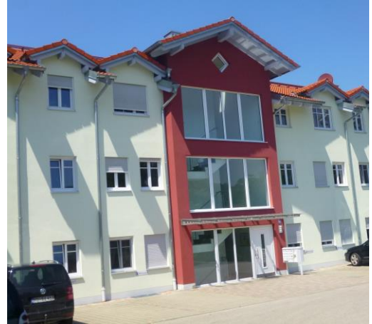
Abb. 109: Verdichtete Wohnanlage mit negativer Zwerggiebelreihung, Dorfstr. 4a, eig. Aufn.
