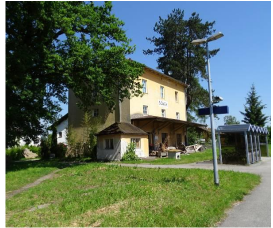
Abb. 102: Sonderbau ehem. Bahnhofsgebäude, eig. Aufn.
