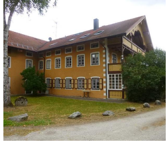
Abb. 106: Ehem. Mühle, Mühlthal, Hs. Nr. 1
