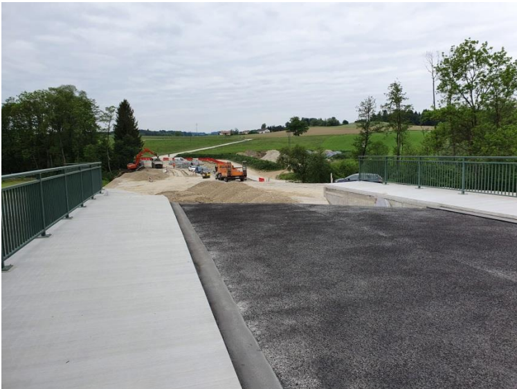
Brücke Mühlthal: das Bauwerk ist fertiggestellt, nun folgt der Straßenbau
