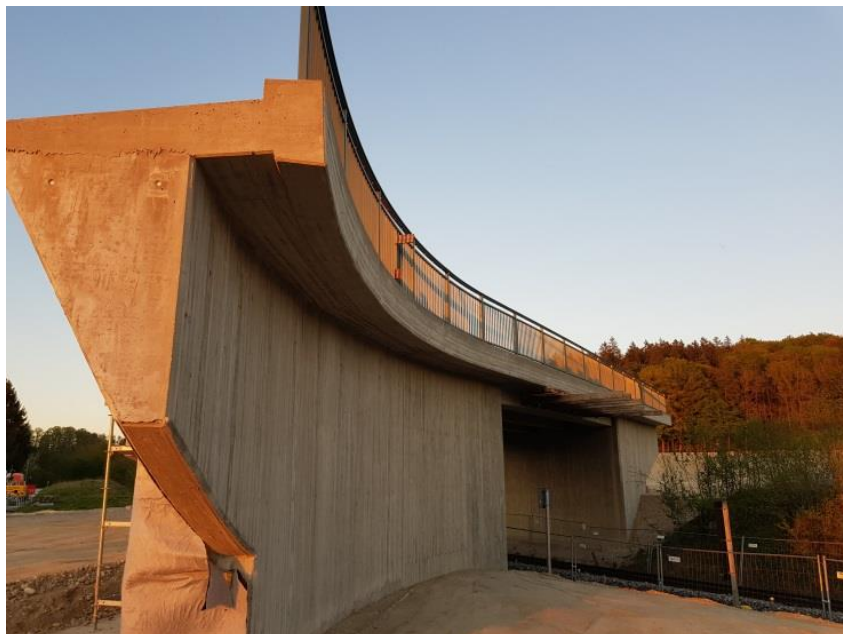
Fertiggestelltes Brückenbauwerk in Mühlthal
