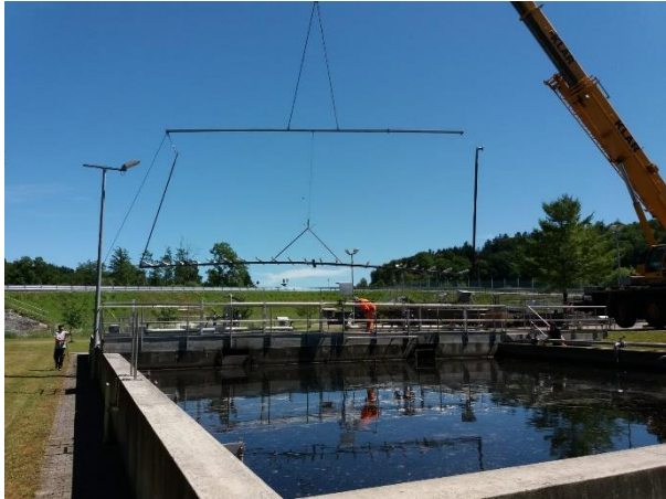
Belüftungskerzen nennen sich die weißen Kunststoffrohre, die zur Sauerstoffzufuhr im Klärbecken eingesetzt werden.
