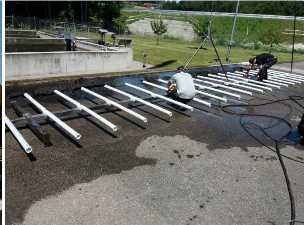
Belüftungskerzen nennen sich die weißen Kunststoffrohre, die zur Sauerstoffzufuhr im Klärbecken eingesetzt werden.
