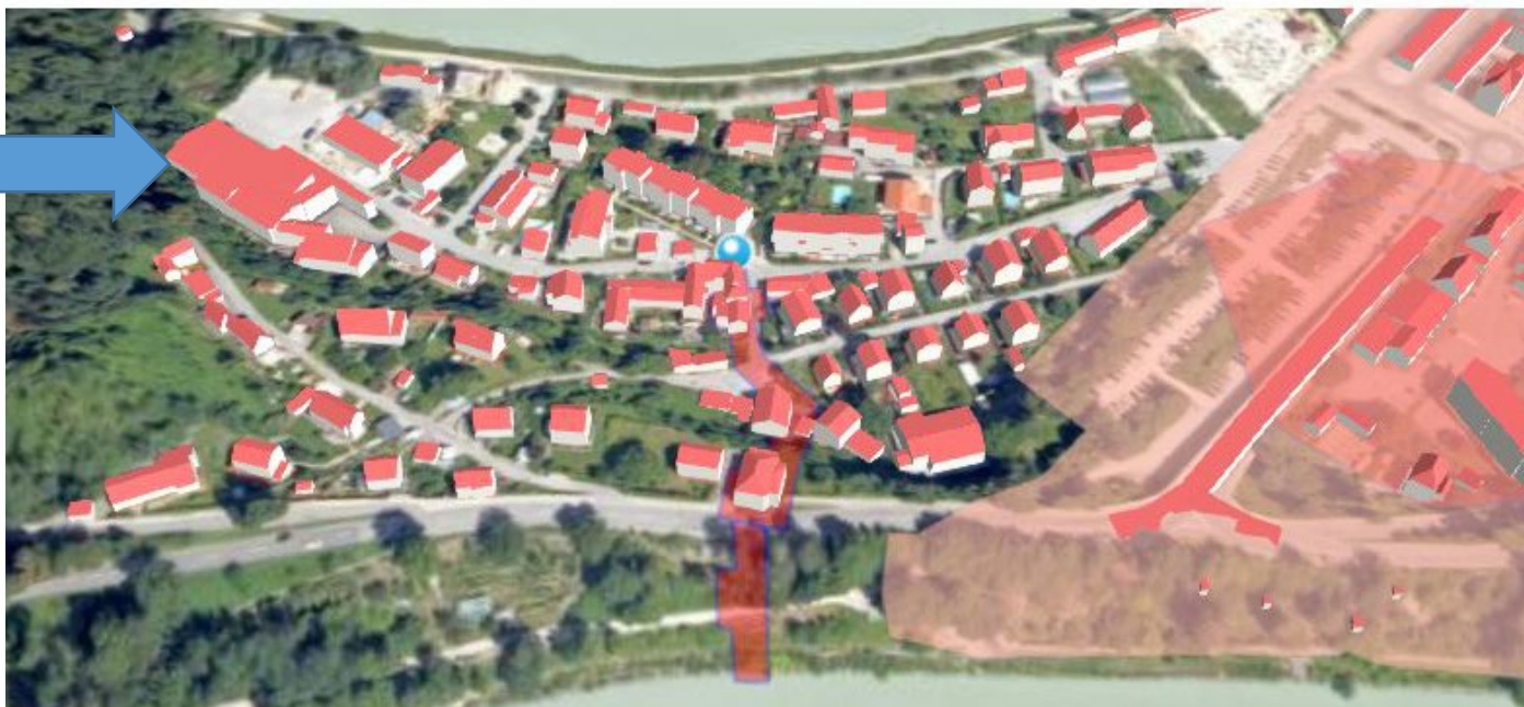
WASSERBURG A. INN, HOLZHOFWEG
