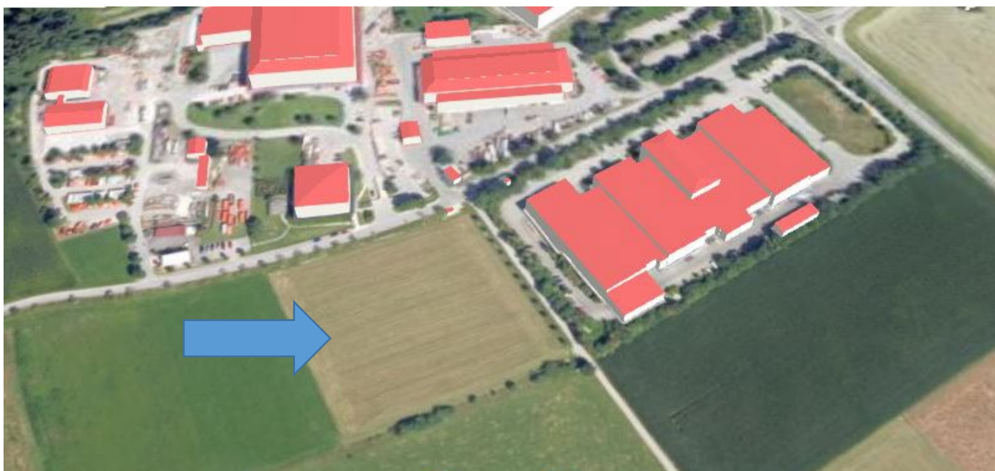
WASSERBURG A. INN, AM BURGFRIEDEN
