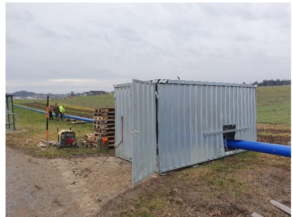
Leitungsverlegung in Höhe Reiching
