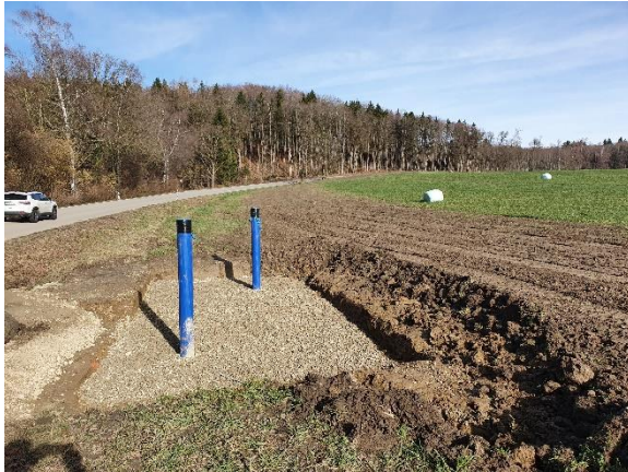
Die Anschlussstelle in Rottmoos
