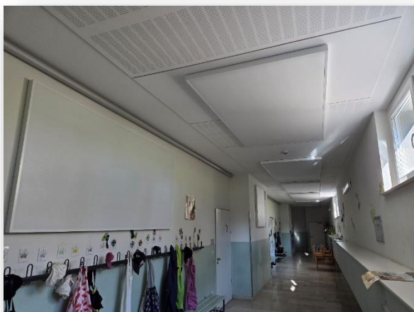
Dämmen den Geräuschpegel – Akustikmaßnahmen in der Grundschule Soyen
